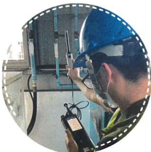
設備機房溫度檢測
